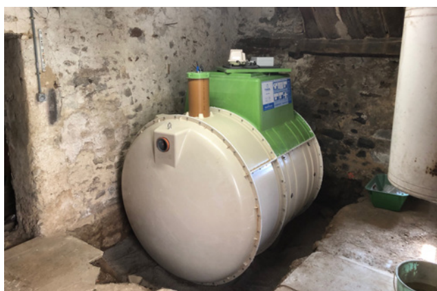
Exemple de pose assimilée enterrée
