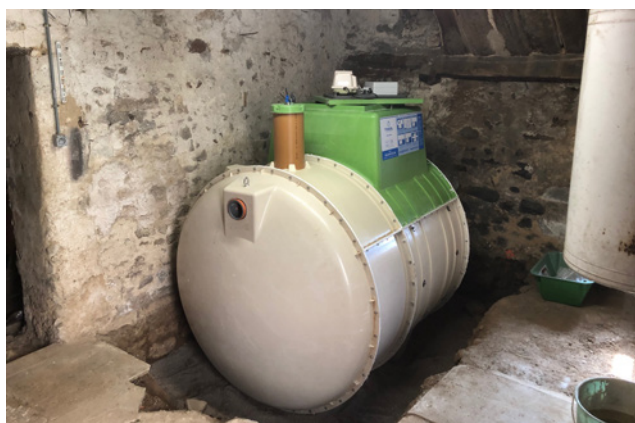
Exemple de pose assimilée enterrée
