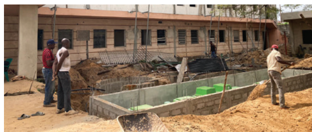
Micro station Tricel Novo 50EH installée au Benin.
