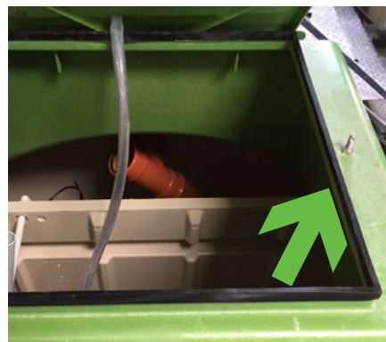
Joints sur un tampon d'accès
