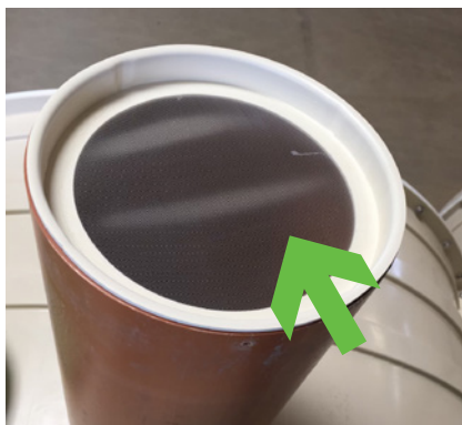
Moustiquaire sur une cheminée de vidange
