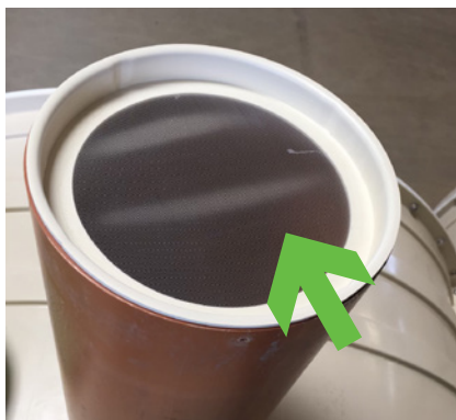
Moustiquaire sur une cheminée de vidange
